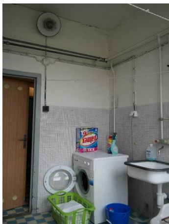
Prádelna před rekonstrukcí
